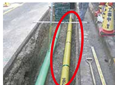
ポリエチレン管への取替作業
