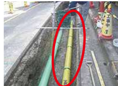
ポリエチレン管への取替作業
