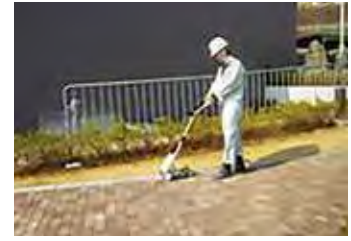
カート式ガス検知器による ガス漏れ調査
