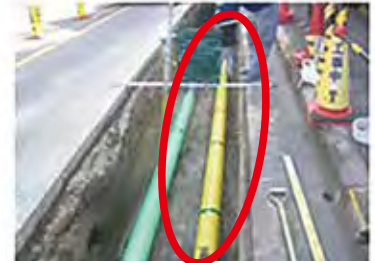
ポリエチレン管への取替作業
