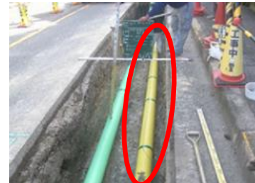
ポリエチレン管への取替作業の様子
